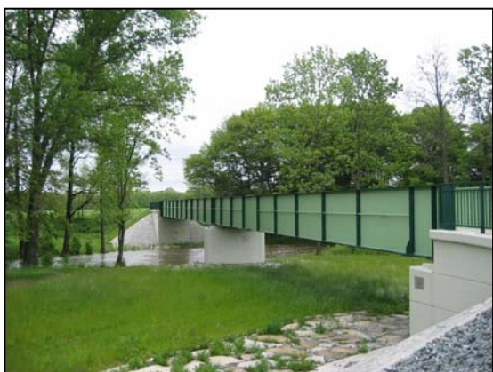
Lávka v Hradišti
